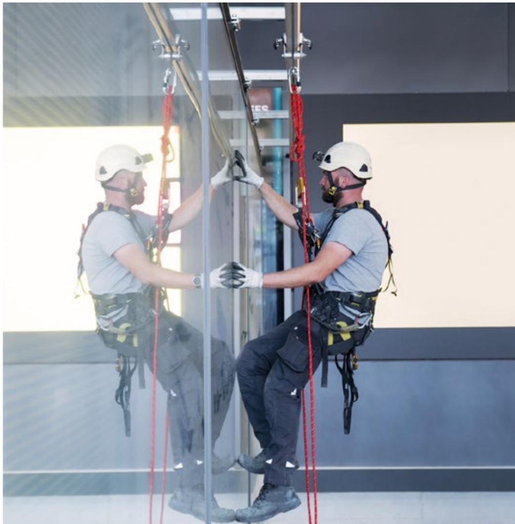
Il SafeAccess per lavori in sospensione è un efficiente sistema di accesso in altezza per la manutenzione e la pulizia delle facciate. Altamente versatile, può essere installato in ingressi di edifici, atri, cortili e sulle facciate principali degli edifici.
