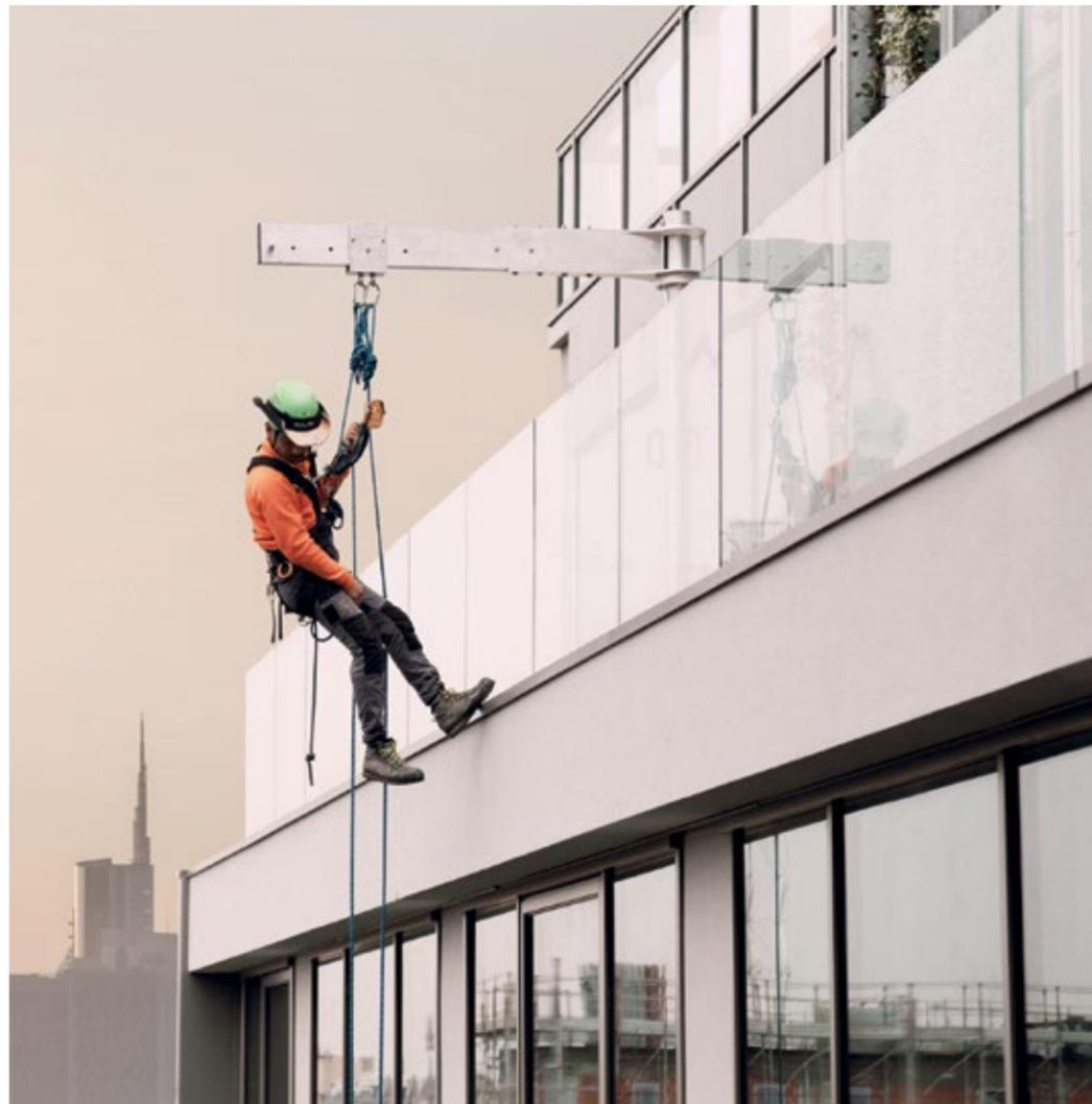
Davit rimovibile progettato per sospendere un lavoratore per eseguire lavori di manutenzione o pulizia su una facciata. Il davit può essere utilizzato da uno specialista dell'accesso su fune, da un sedile RopeClimber o da una navicella singola Ropeclimber. Il davit è fissato al tetto con basi installate in modo permanente lungo il perimetro dell'edificio. Al termine del lavoro, il davit viene smontato e riposto.
