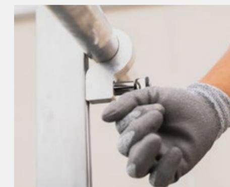
Si può regolare direttamente in cantiere l'altezza della traversina inferiore sul montante in base all'altezza del muretto perimetrale.
